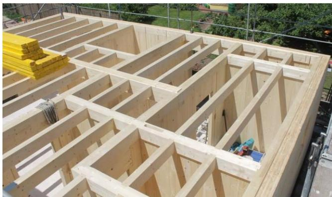
Die Holzbauweise hat eine lange Tradition. Eine weitreichende Entwicklung begann mit der Möglichkeit der industriellen Vorfertigung und mit modernen Holzwerkstoffen. In Werkhallen können mittlerweile die Holzbauweise wie z.B. Wände, Decken und Dächer vor der Witterung geschützt, gedämmt, beplankt, mit Fenster, Innenbeplankung und Installationen usw. bestückt, hergestellt werden.
