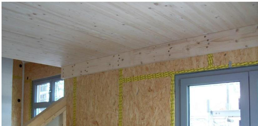
Wichtig ist hier eine sorgfältige Verarbeitung und der luftdichte Anschluss aller Bauteile, wie z.B. Fenster und Türen, oder auch Dach- und Deckenflächen an den Außenwänden. Um Bauschäden zu vermeiden, darf es auf keinen Fall zu Undichtigkeiten, z.B. durch Beschädigungen oder Durchdringungen von z.B. Elektrokabeln usw. kommen.
